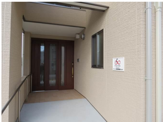
段差のない大開口玄関
